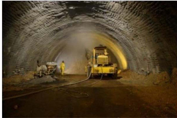
شکل ۷-۱. اجرای تحکیمات اولیه تونل مترو تهران
