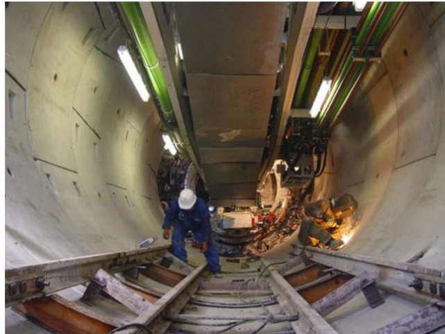
شکل ۱۴-۱. اجرای تحکیمات تونل انتقال آب دز به قمرود
