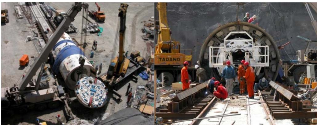
شکل ۱۵-۱ اتصال دستگاه حفاری TBM با سپردوگانه در تونل انتقال آب کرج به تهران
