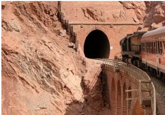
شکل ۶-۱. تونل گدوک در مسیر راه آهن مازندران
