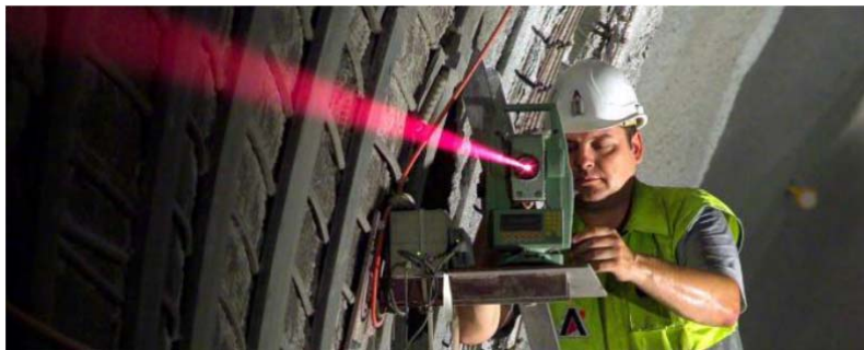
شکل ۱-۱. کنترل قاب فلزی تونل توسط مهندس نقشه بردار
