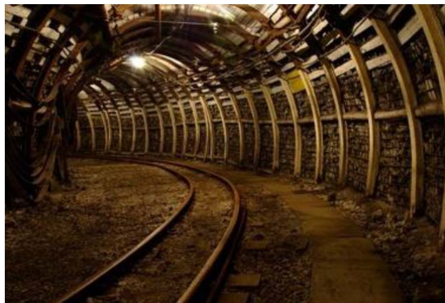
شکل ۱۰-۱: تونل معدنی مهار شده به وسیله قاب فلزی در چین
