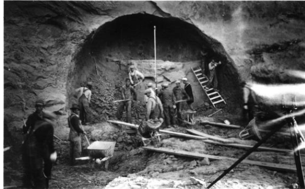
شکل ۱-۲. حفاری دستی و نقشه برداری در تونل NARA سال ۱۹۵۳
