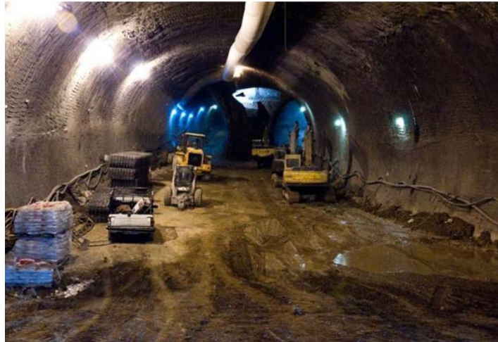
شکل ۱۳-۱. تونل نیایش در حال اجرا
