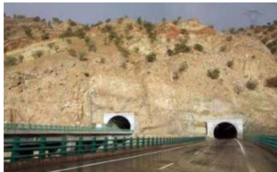
شکل ۵-۱. تونل های دوقولو در مسیر آزاد راه خرم آباد- پل زال
